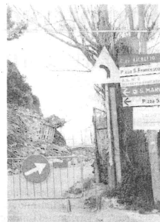
Chiusa da otto mesi La frana sulla Ss 283 risale al mese di gennaio
