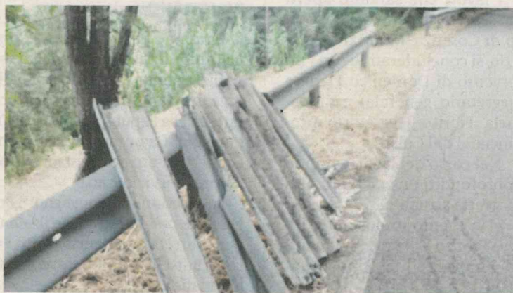
Le lastre di eternit Si scorgono lungo la Provinciale 114
